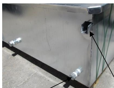
SALIDA VÁLVULA DE DRENAJE
