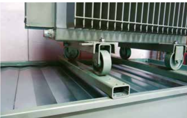
Ruedas de transformador
